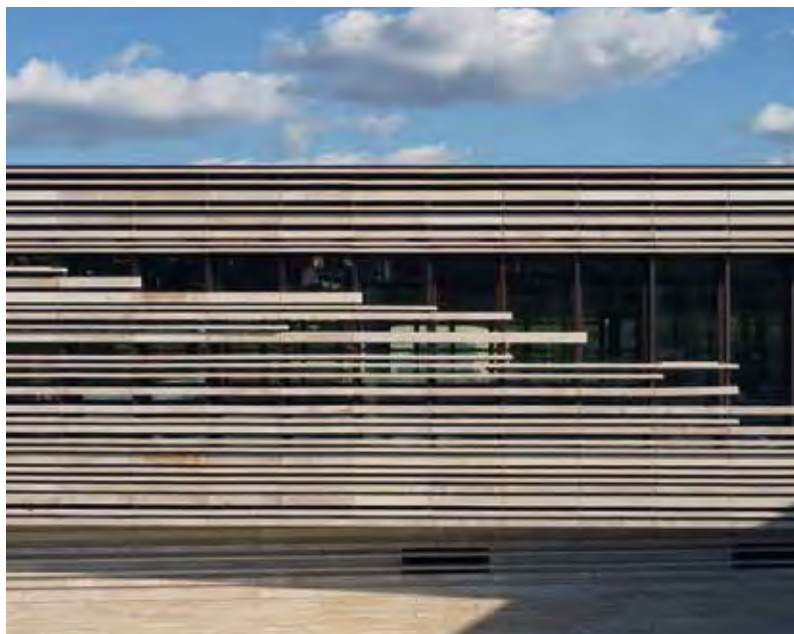
Le facciate sono schermate da pietra locale che in parte diventa frangisole e in parte parete ventilata
