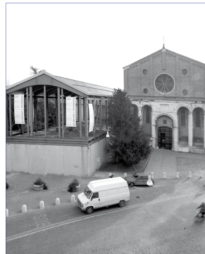
L'avancorpo in costruzione
